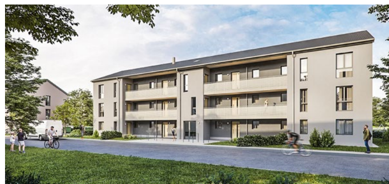
Mit Laubengängen: drei Häuser in dreigeschossiger Bauweise im Süden von Ahlen
