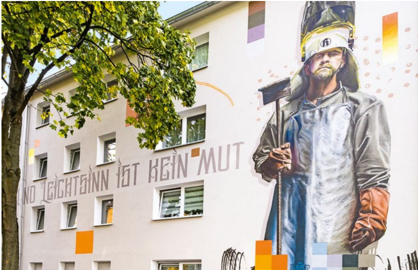
Dortmunder Graffiti-Künstler gestalten die Fassaden der frisch modernisierten Häuser, hier ein Beispiel aus der Unnaer Straße
