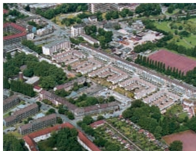
Die CEAG-Siedlung in Dortmund ist eines der Projekte, die im Rahmen der IBA Emscher Park entwickelt wurden
