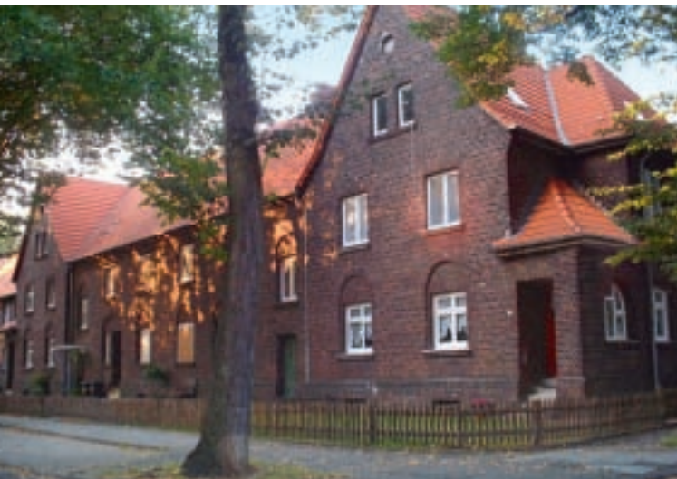
Beispiel für eine gelungene Privatisierung von Altbauten: frühere Bergarbeitersiedlung in Duisburg-Wehofen
