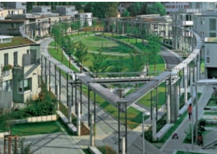
Siedlung Küppersbusch in Gelsenkirchen. Den Grünflächen kommt ein Regenwasser-Sammelsystem zugute
