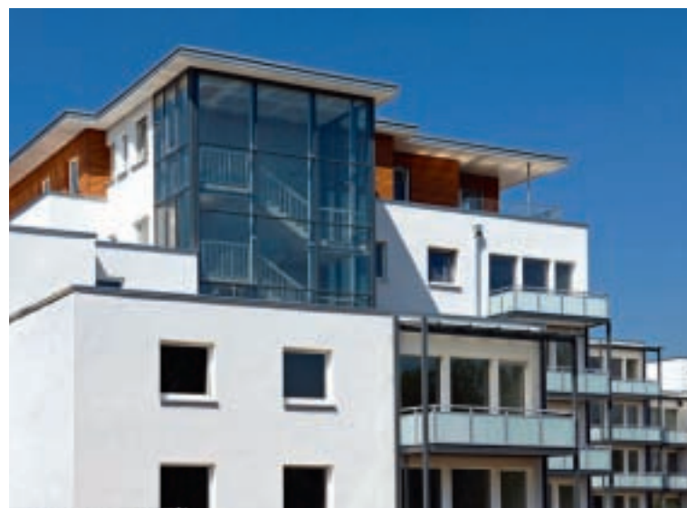
Transparent, hell, großzügig, freundlich und wohnlich: der Schillerpark nach Rückbau und Modernisierung
